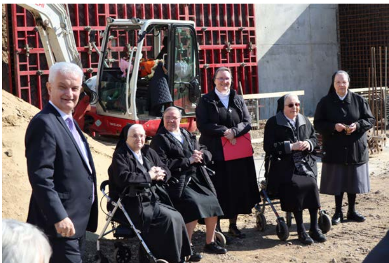
Oben: Sie legten gemeinsam die Zeitkapsel in das Fundament: Dr. Michael Hitzschke, Hauptgeschäftsführer der TGE gTrägersgesellschaft für die Einrichtungen der Schwestern vom Göttlichen Erlöser (Niederbronner Schwestern), Matthias Bauernfeind, Oberbürgermeister der Stadt Bühl, Sr. Barbara Geißinger, Provinzoberin der Schwestern vom Göttlichen Erlöser (Niederbronner Schwestern) und Alfred Krampfert, Bauunternehmer und Investor (von links nach rechts)
