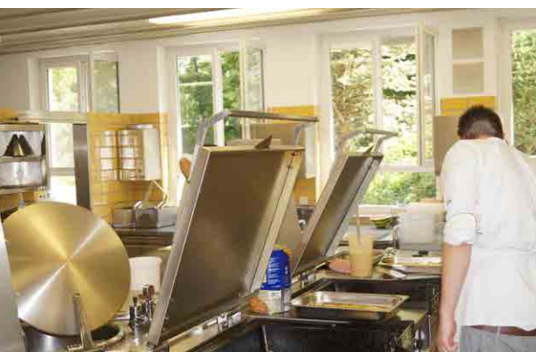
Foto oben: Mit dem Kompressor wird die ehemalige Klosterküche entkernt Foto mitte: Beim Verladen der alten Küchenteile Foto unten: Die Küche im Haus St. Marien
